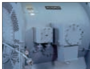
Haupt- und Hilfsanschlusskästen in Zündschutzart Exd IIC
