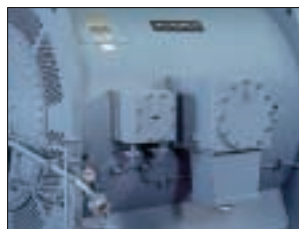
Haupt- und Hilfsanschlusskästen in Zündschutzart Exd IIC
